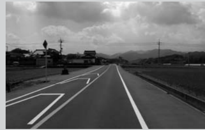
旧上山田線東川崎駅跡付近
