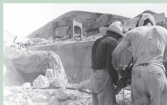
▲閉山後、解体される大峰炭鉱
