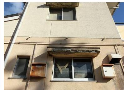
窓庇のモルタルの破損
