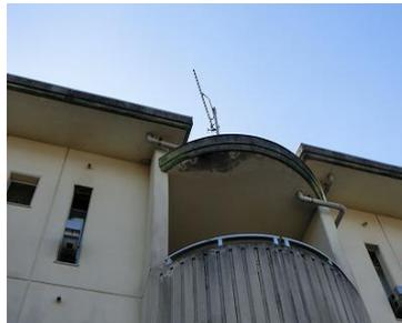
階段室庇裏の雨水の浸入跡・爆裂
