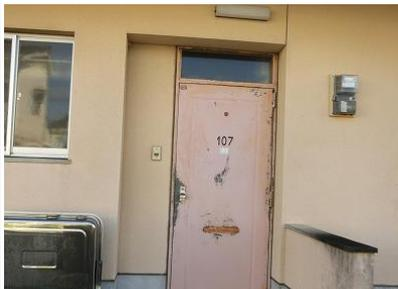
玄関扉枠の錆と塗装の劣化
