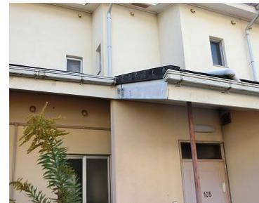
庇側面の板材の塗装の劣化
