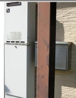
鉄骨柱の塗装劣化（剥がれ）
