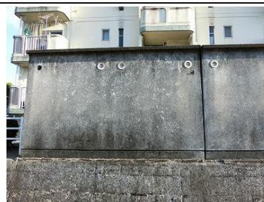
100 号棟倉庫棟の壁面の汚れ、塗装の劣化
