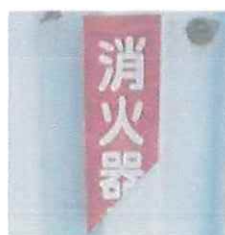
× 標識の破損
