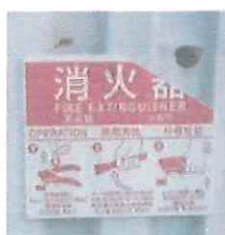
× 標識の破損
