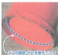
× 底部の腐食
