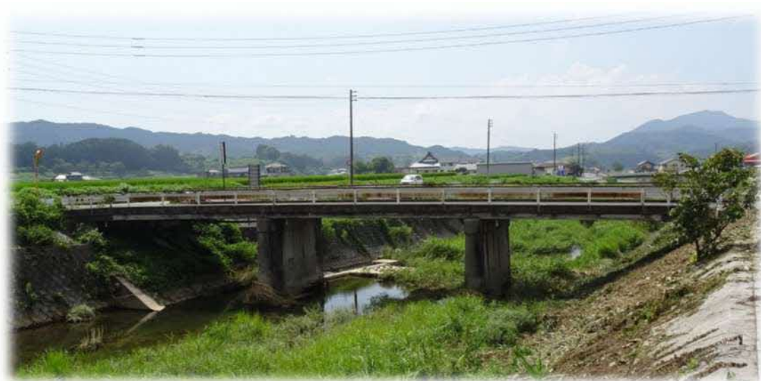
「柏木橋（1971年架設）」
