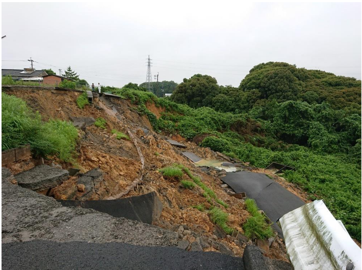
写真：豪雨による高見団地土砂崩れ（平成 30 年 7 月）
